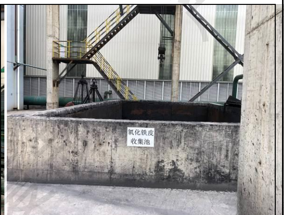
铁皮池沉淀污泥
