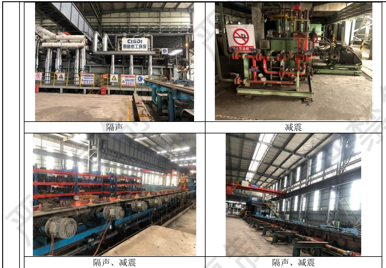
图 2.3-10 隔声措施建设情况
