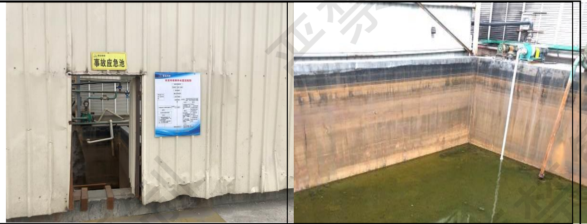
特钢公司已建的 300m 3 事故应急池
