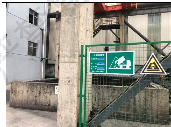
浊环水处理系统污泥暂存池
